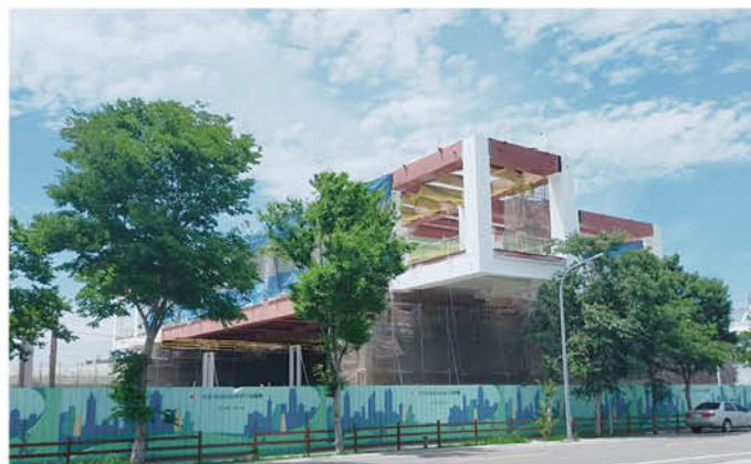
■ 目前正在興建中的北回歸線車站
