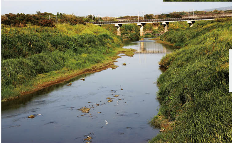
■ 跨越八掌溪臺鐵縱貫線鐵橋
