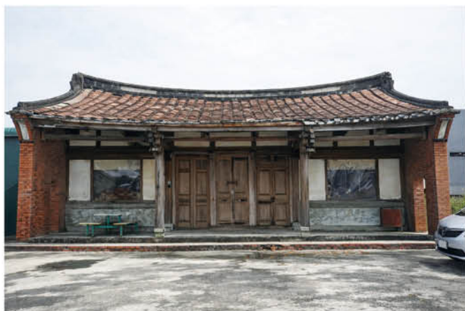
■ 美源居修復前舊照
