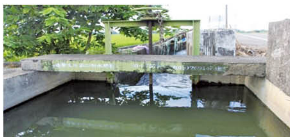
道爺圳支線制水閘門
