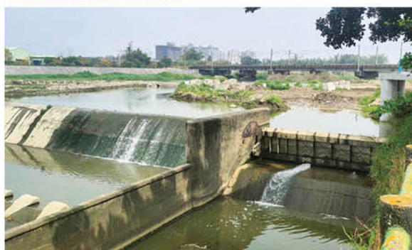
柳子溝圳倒伏堰
