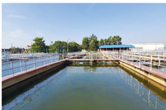
淨水場內的水池
