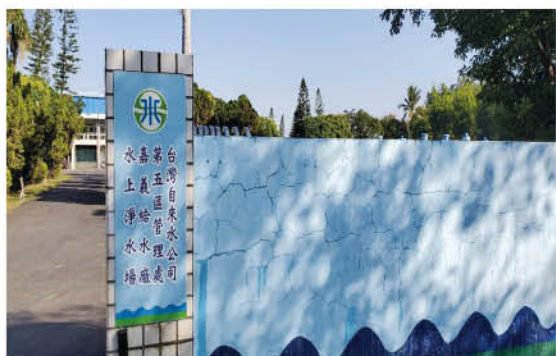
嘉義給水廠水上淨水場
