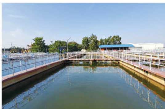
淨水場內的水池
