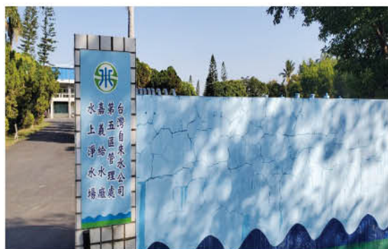
嘉義給水廠水上淨水場
