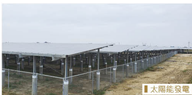
■ 浮動式太陽能配電室
