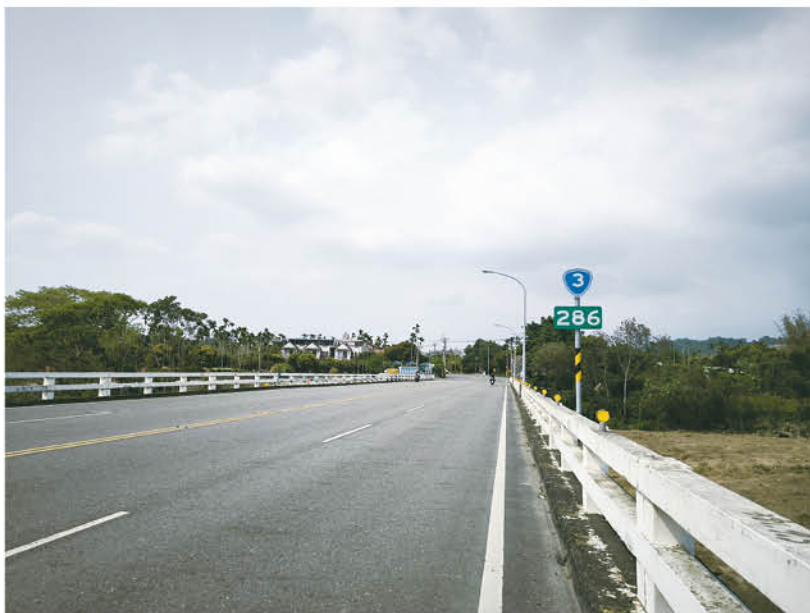
■ 台3線，經過番路鄉，是從臺北到屏東的重要道路。
