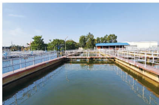
淨水場內的水池
