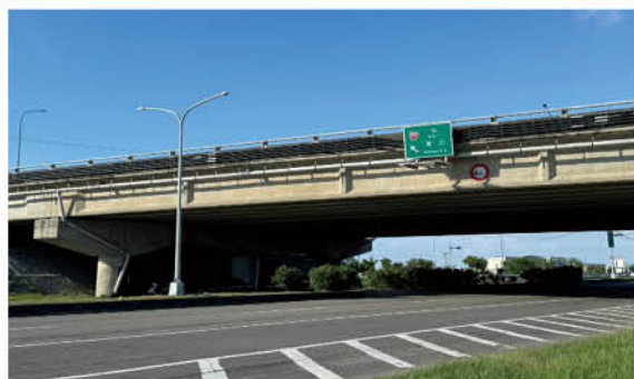
■ 高架區段的快速道路
