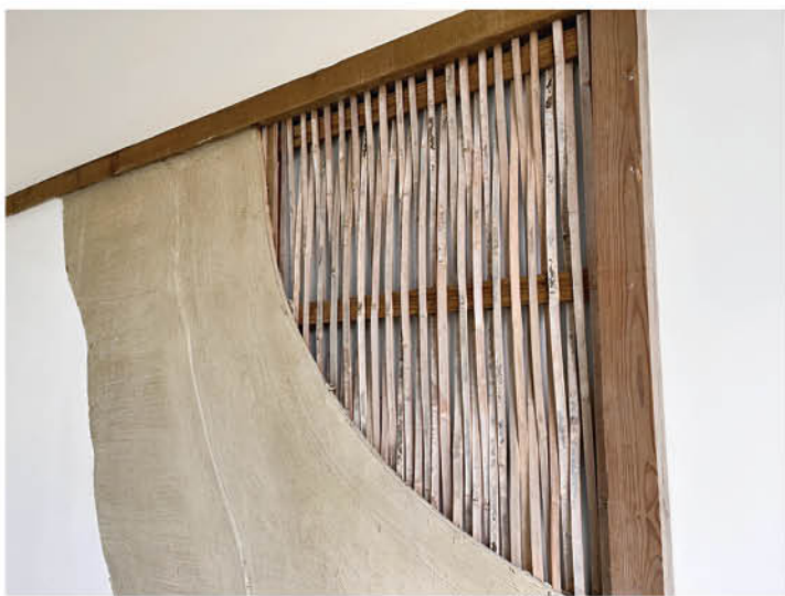
■ 國寶級古蹟修復職人蘇清良先生，示範過去車站和當地民居使用的「編竹夾泥牆工法」。
