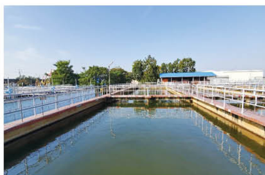
淨水場內的水池
