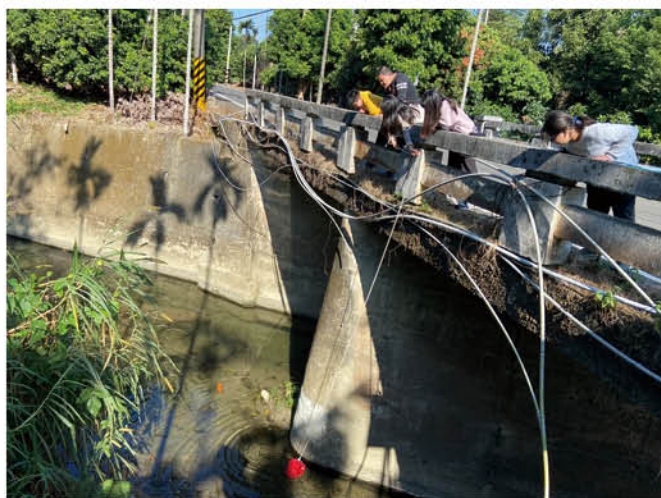
堤岸整治後的三疊溪
