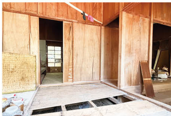
■ 十字路車站站長宿舍室內環境
