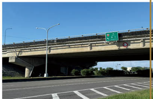
高架區段的快速道路
