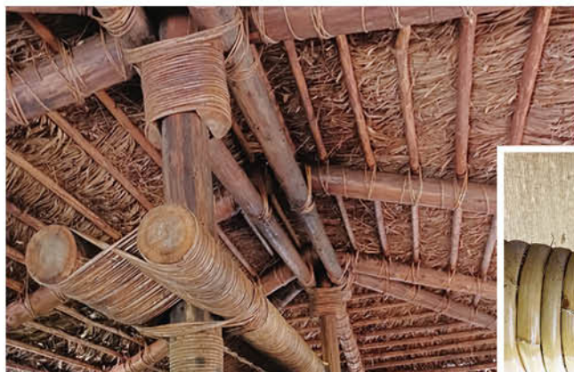
達娜伊谷園區內傳統家屋梁柱的藤條
