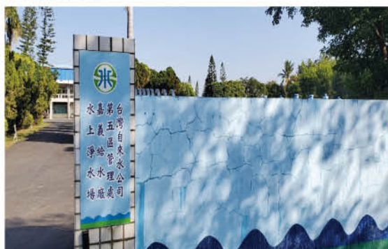
■ 嘉義給水廠水上淨水場
