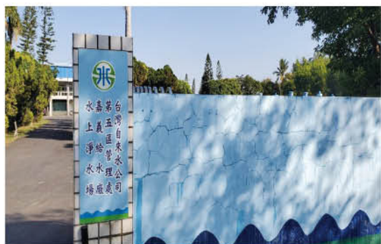
嘉義給水廠水上淨水場
