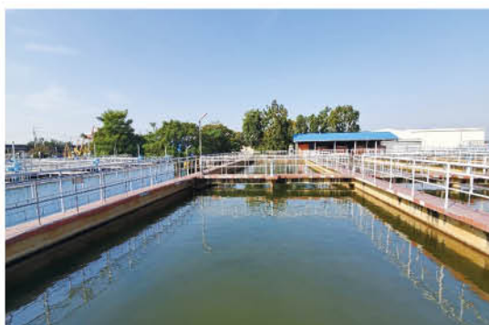
淨水場內的水池
