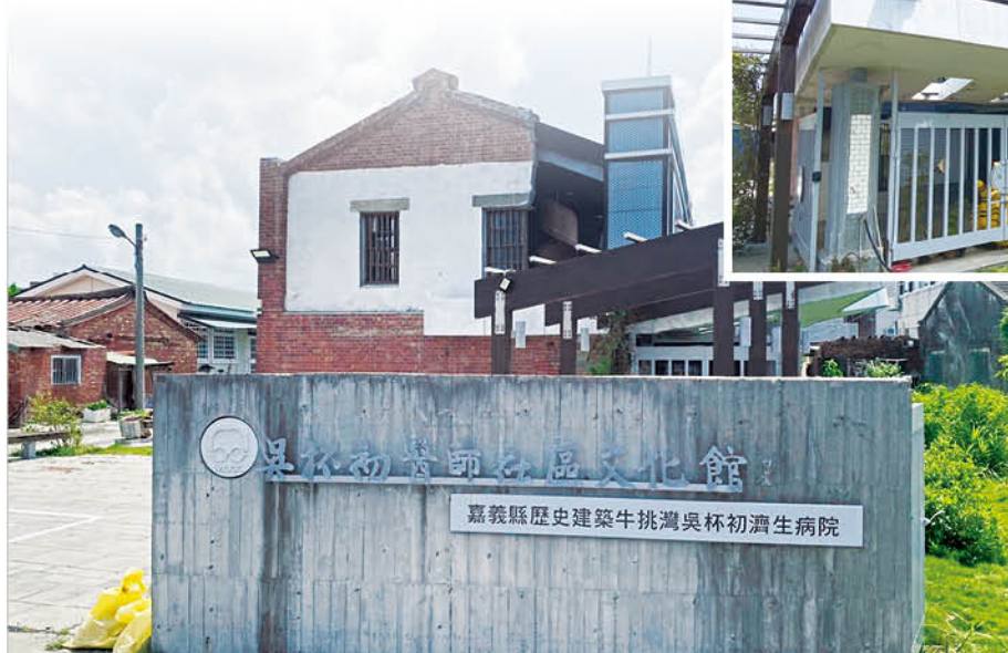
修復後濟生醫院外觀
