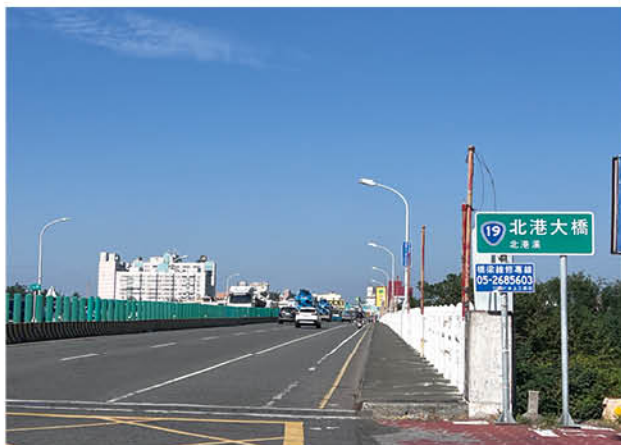
■ 連接六腳鄉與北港鎮的北港大橋
