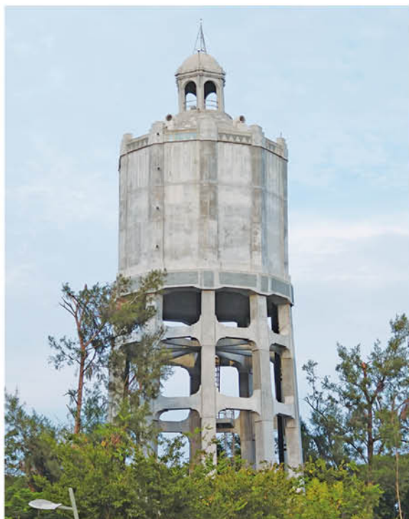
■ 朴子水道頭配水塔
