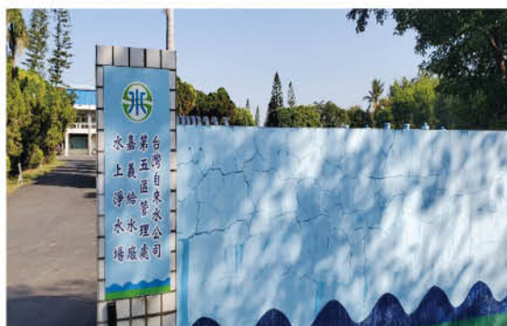
■ 嘉義給水廠水上淨水場
