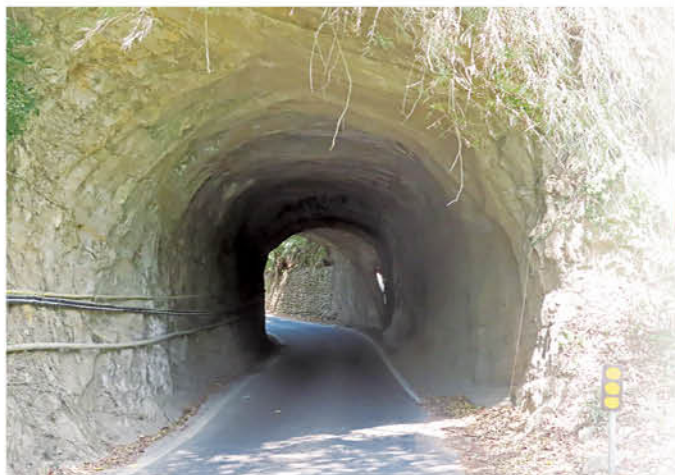
藤寮隧道全景
