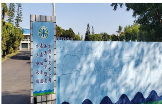
■ 嘉義給水廠水上淨水場
