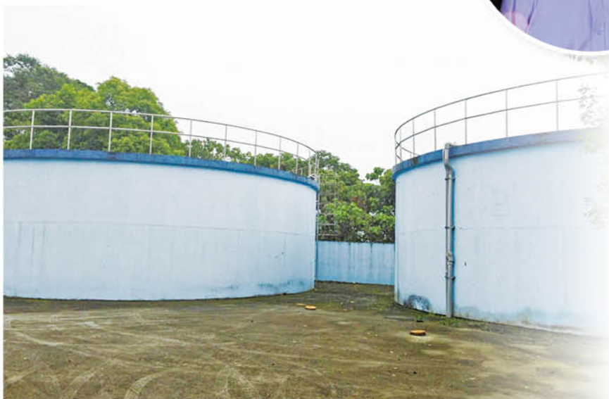
■ 中埔鄉最早的自來水廠，現址為自來水廠淨水池
