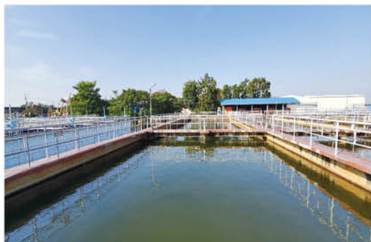
■ 淨水場內的水池
